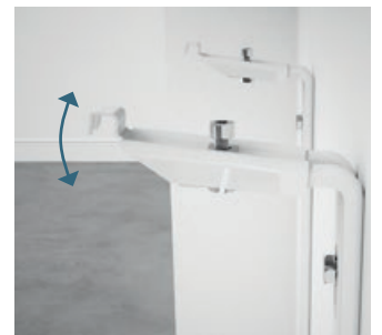
vor dem Einsetzen des Heizkörpers wird das Oberteil gelöst
